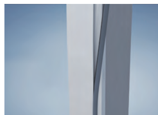
Mitgeliefertes Dichtungsprofil in die Zargennut einlegen
