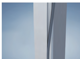
Mitgeliefertes Dichtungsprofil in die Zargennut einlegen
