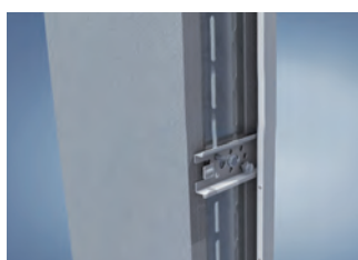
Alle Trapezanker mit Schrauben am UA-Profil befestigen. Nach Erfordernis unterfüttern
