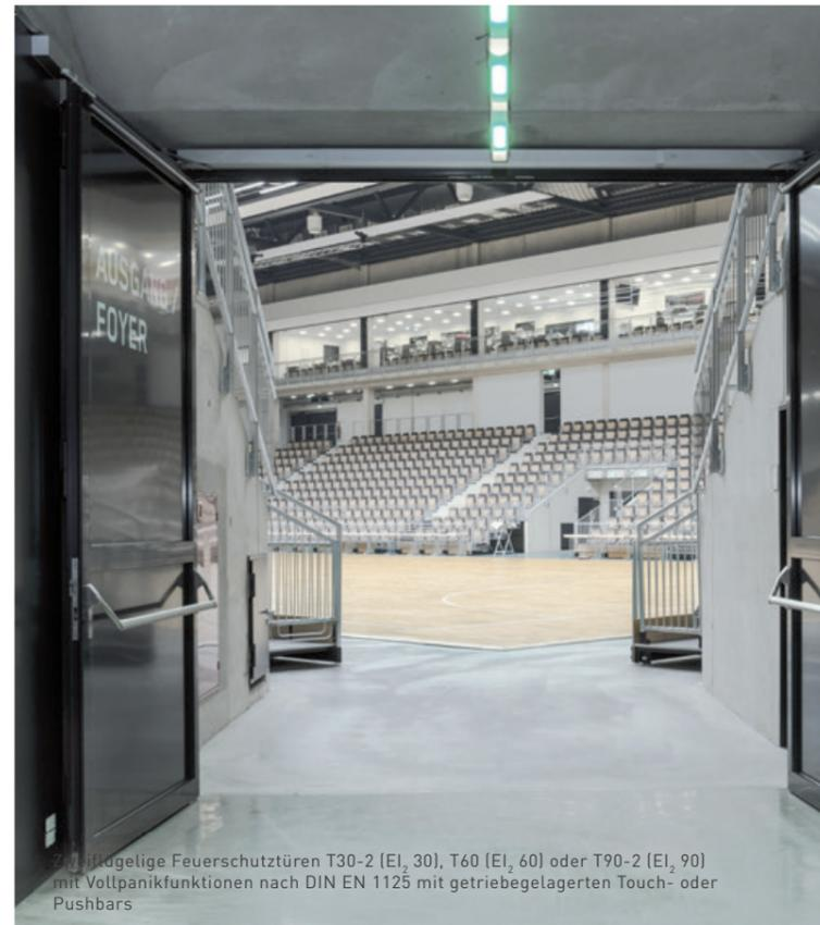
Zweiflügelige Feuerschutztüren T30-2 (EI<sub>2</sub> 30), T60 (EI<sub>2</sub> 60) oder T90-2 (EI<sub>2</sub> 90) mit Vollpanikfunktionen nach DIN EN 1125 mit getriebegelagerten Touch- oder Pushbars
