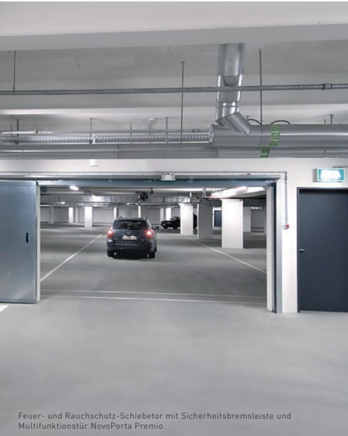
Feuer- und Rauchschutz-Schiebetor mit Sicherheitsbremsleiste und Multifunktionsstür NovoPorta Premio
