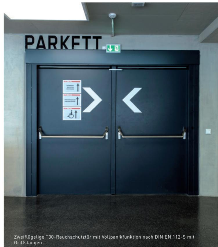
Zweiflügelige T30-Rauchschutztür mit Vollpanikfunktion nach DIN EN 112-S mit Griffstangen
