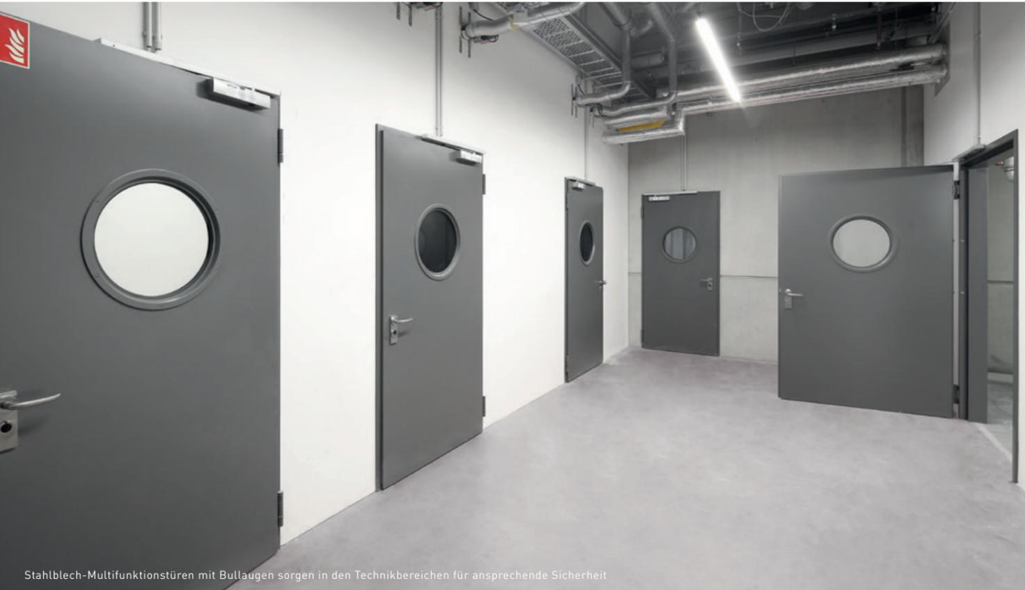
Stahlblech-Multifunktionsüren mit Bullaugen sorgen in den Technikbereichen für ansprechende Sicherheit
