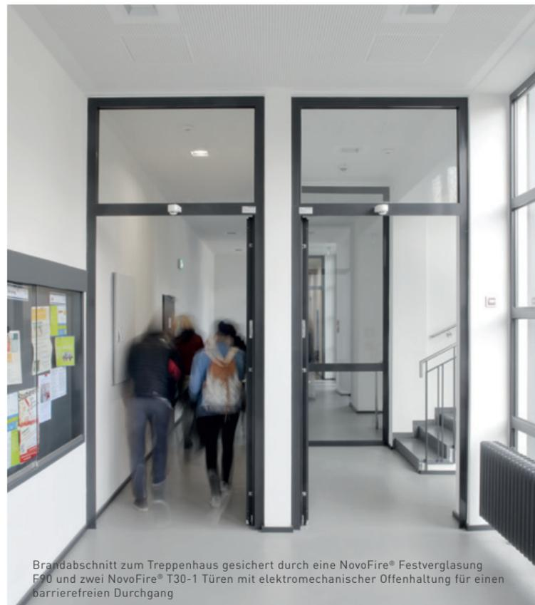
Brandabschnitt zum Treppenhaus gesichert durch eine NovoFire® Festverglasung F90 und zwei NovoFire® T30-1 Türen mit elektromechanischer Offenhaltung für einen barrierefreien Durchgang
