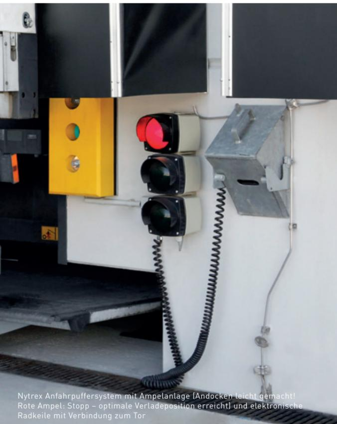
Nytrex Anfahrpuffersystem mit Ampelanlage (Andocken leicht gemacht! Rote Ampel: Stopp – optimale Verladeposition erreicht) und elektronische Radkeile mit Verbindung zum Tor
