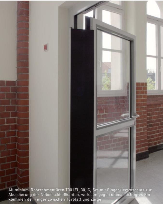
Aluminium-Rohrrahmentüren T30 (EI<sub>2</sub> 30) C<sub>5</sub> Sm mit Fingerklemmschutz zur Absicherung der Nebenschließkanten, wirksam gegen unbeabsichtigtes Einklemmen der Finger zwischen Türblatt und Zarge
