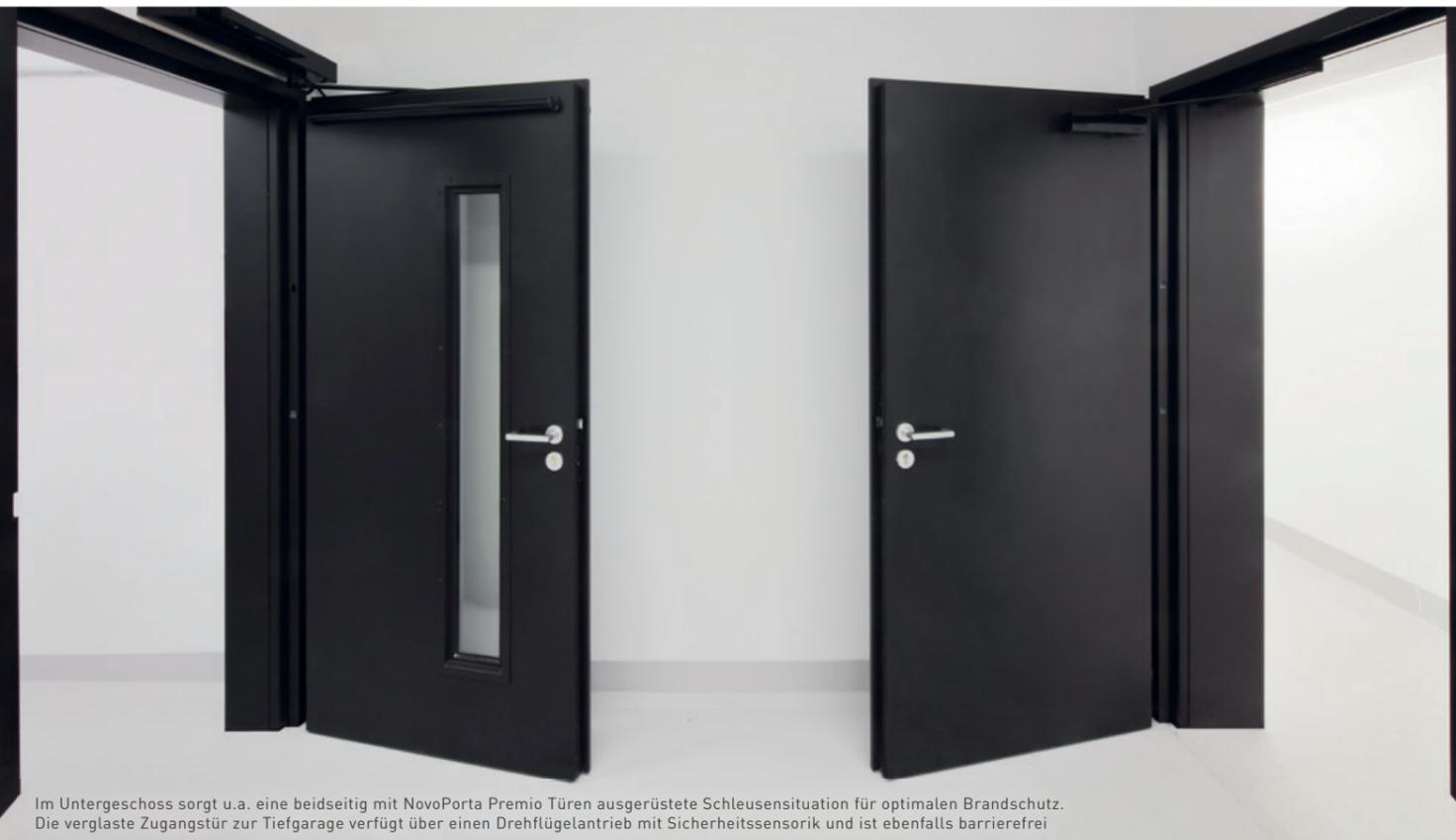
Im Untergeschoss sorgt u.a. eine beidseitig mit NovoPorta Premio Türen ausgerüstete Schleusensituation für optimalen Brandschutz. Die verglaste Zugangstür zur Tiefgarage verfügt über einen Drehflügelantrieb mit Sicherheitssensorik und ist ebenfalls barrierefrei
