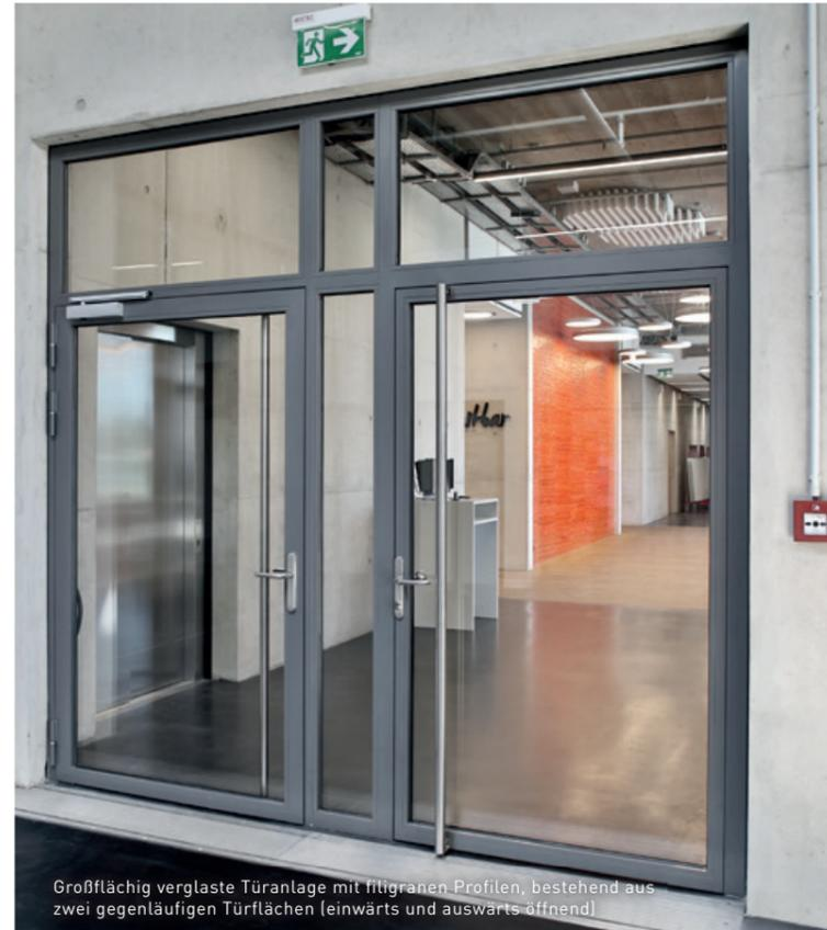
Großflächig verglaste Türanlage mit filigranen Profilen, bestehend aus zwei gegenläufigen Türflächen (einwärts und auswärts öffnend)
