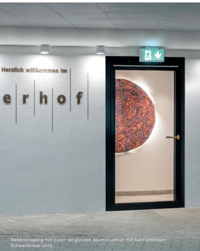
Nebeneingang mit einer verglasten Aluminiumtür mit barrierefreier Schwellenvariante
