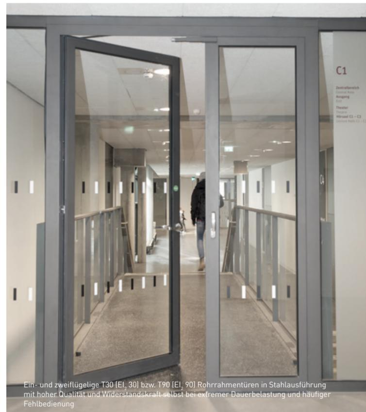
Ein- und zweiflügelige T30 [EI<sub>2</sub> 30] bzw. T90 [EI<sub>2</sub> 90] Rohrrahmenüren in Stahlausführung mit hoher Qualität und Widerstandskraft selbst bei extremer Dauerbelastung und häufiger Fehlbedienung
