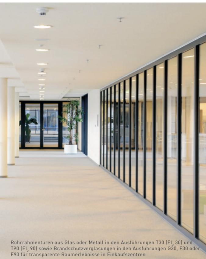
Rohrrahmentüren aus Glas oder Metall in den Ausführungen T30 (EI<sub>2</sub> 30) und T90 (EI<sub>2</sub> 90) sowie Brandschutzverglasungen in den Ausführungen G30, F30 oder F90 für transparente Raumerlebnisse in Einkaufszentren
