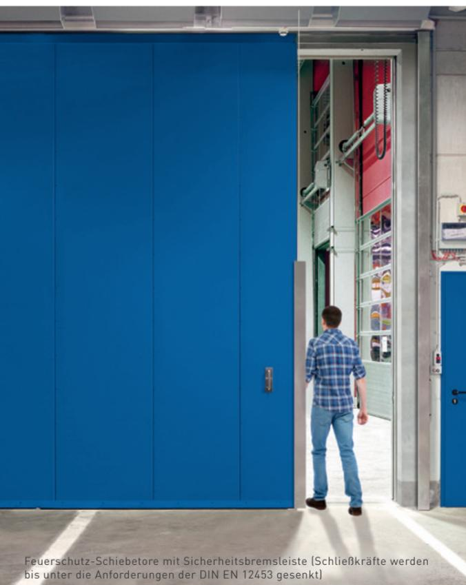
Feuerschutz-Schiebetore mit Sicherheitsbremsleiste (Schließkräfte werden bis unter die Anforderungen der DIN EN 12453 gesenkt)
