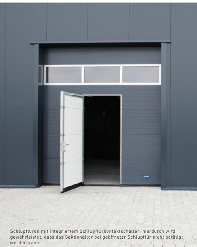
Schlupftüren mit integriertem Schlupftürkontaktschalter; hierdurch wird gewährleistet, dass das Sektionaltor bei geöffneter Schlupftür nicht betätigt werden kann
