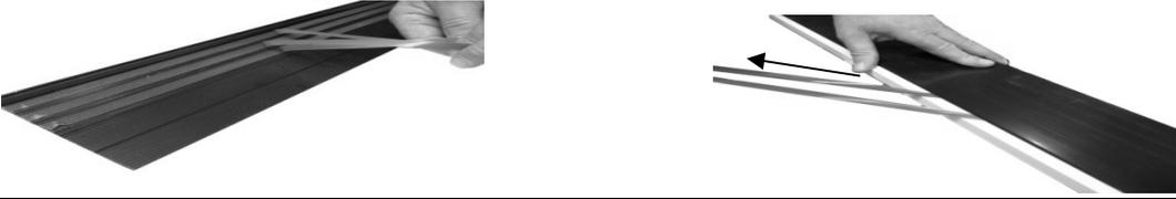
**5** Dichtung befestigen und kürzen
