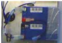
Brancher la batterie de la pile côté moteur. Appuyer sur le bouton manœuvré de dépannage pour desserrer le frein moteur. Régler le support galet bas à 100mm du sol.
